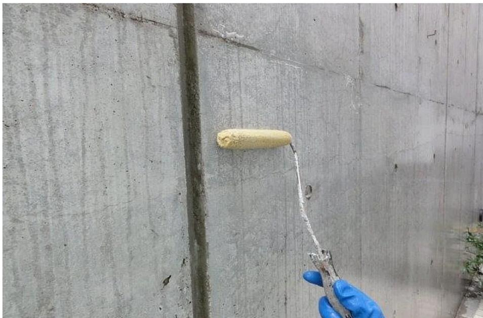
Sクリートアップ⇒Sクリートクラック⇒Sクリートガードの3工程でクラックからの漏水は確実に止水できます。3工程ですがSクリートアップとSクリートクラックは追っかけ作業ですので時間はかかりません。翌日Sクリートガードを塗布して終了です。クラックをVカットせず綺麗に補修ができて、長期間止水・防水が可能になります。
