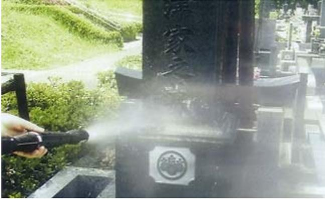
高温の蒸気を噴出させて汚れを落とす。
